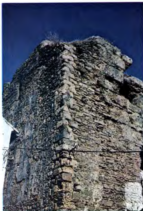
Angulo del cubo de la Torre del Homenaje, con silleria a escuadra y los planos de argamasa y mampuestos.
