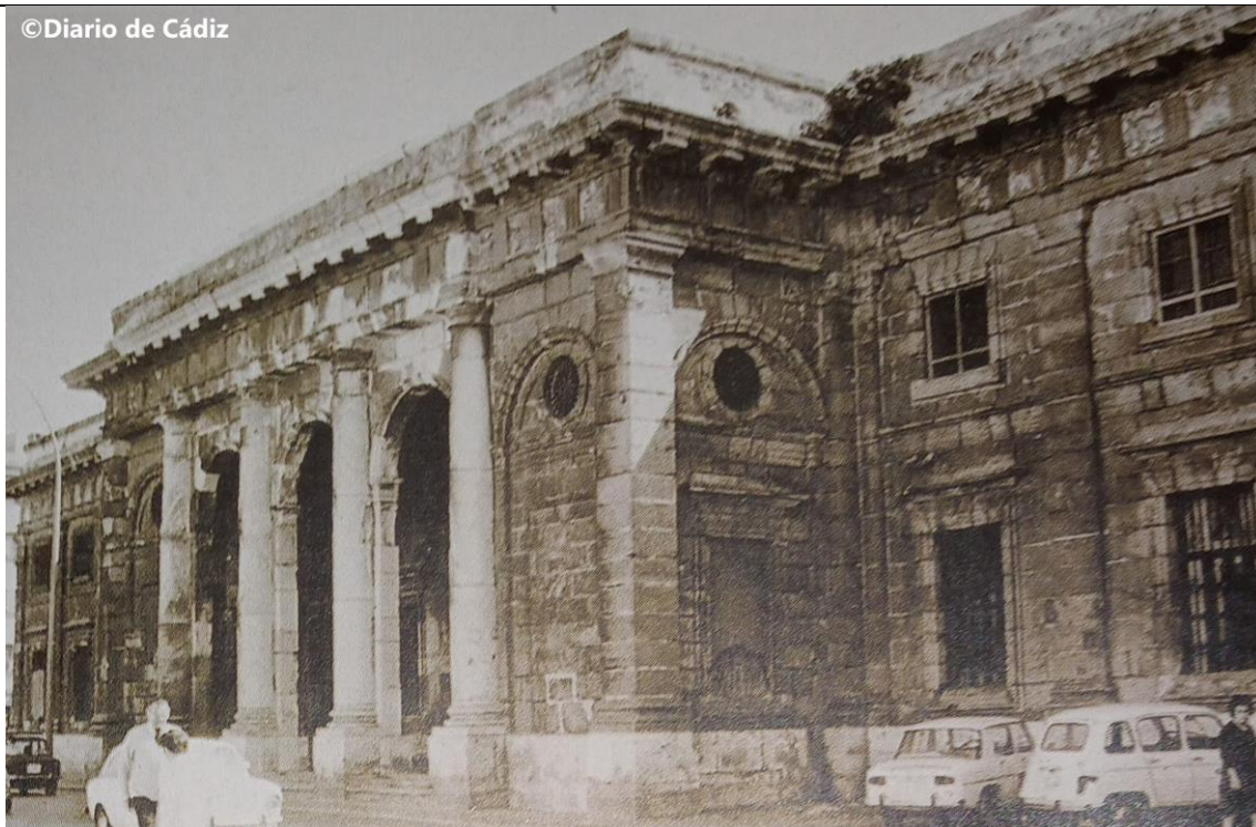
Antigua Cárcel Real prácticamente en ruinas en 1986. Fuente: ©Diario de Cádiz
