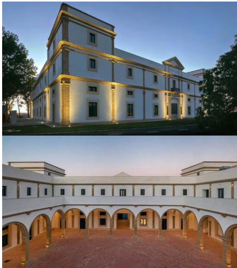
Actualidad del exterior e interior del Penal de las Cuatro Torres tras su rehabilitación. Fuente: ©Internet
