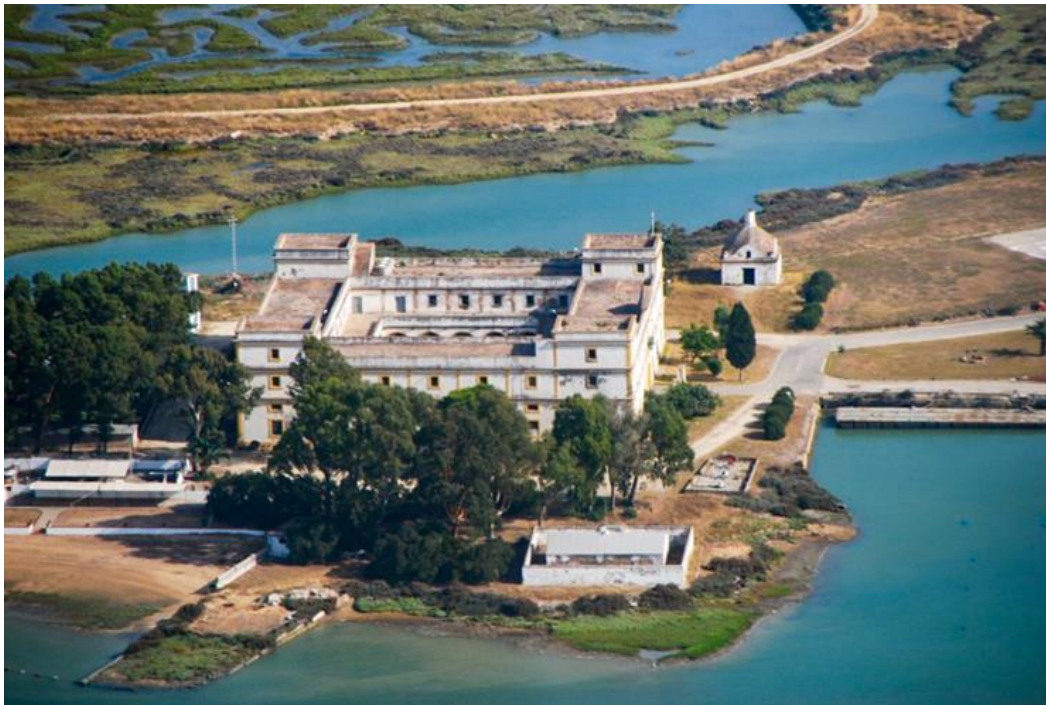
Vista aérea del Penal de las Cuatro Torres antes de su rehabilitación. Fuente: ©Internet
