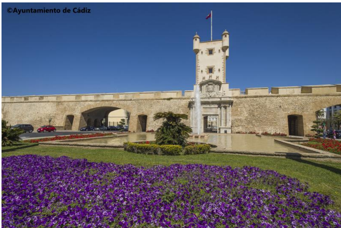
Muros de Puerta de Tierra. Fuente: ©Ayuntamiento de Cádiz
