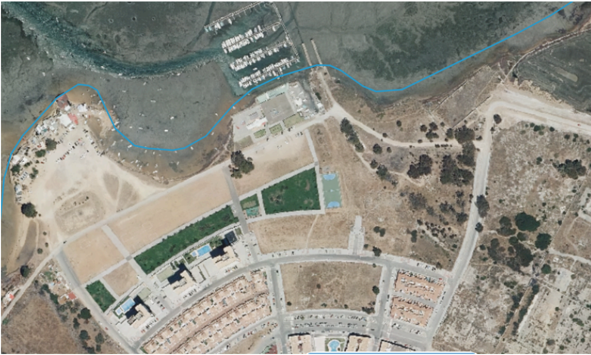
Vista de Casería en 2019, ya con la integración de las tres torres vivienda y las instalaciones náutico-deportivas. Los chiringuitos de la playa aún no habían sido demolidos (CNIG).
