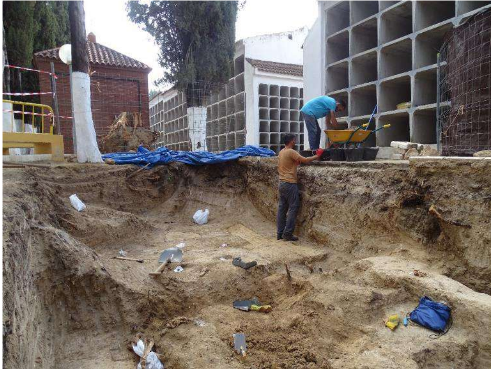
Limpieza, rebaje y extracción manual de sedimentos, así como delimitación de enterramientos en la zona ampliada hacia el Este. Vista desde el norte.
