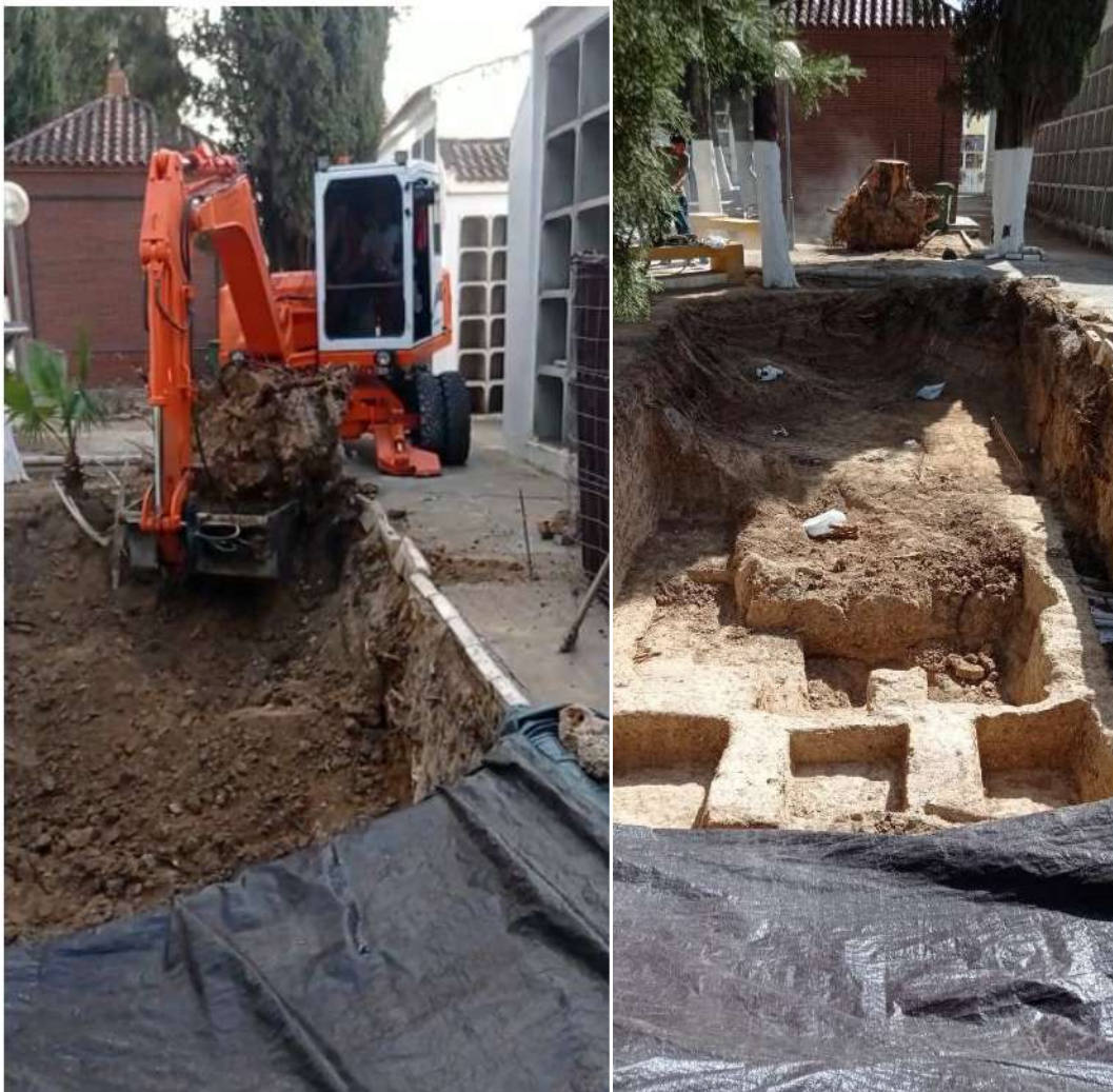
Trabajos de ampliación del área a intervenir hacia el Este y extracción de raíz de ciprés.
