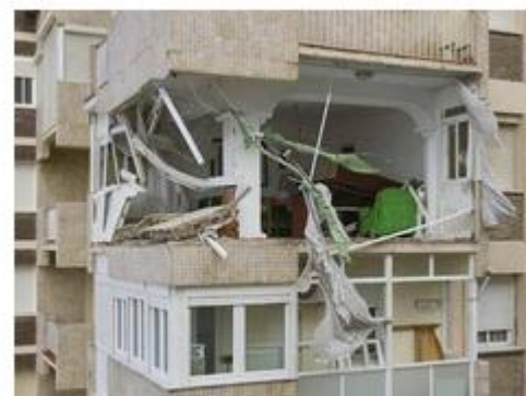
Estado en el que quedó una vivienda en el paseo marítimo de Cádiz tras el tornado. EDUARDO RUIZ
